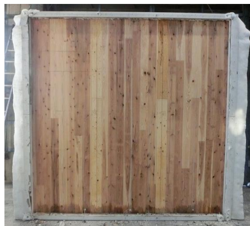
試験後の内部 CLT 表面の様子
